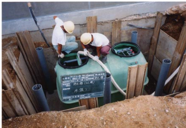
合併処理浄化槽の設置作業
